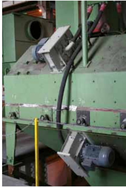
Modernisering en capaciteitsverhoging van gebruikte installaties onder andere met moderne turbine-techniek.
