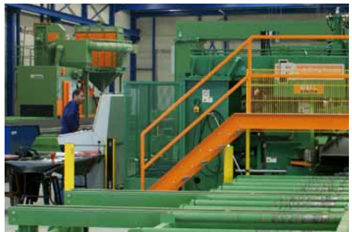
Aanzicht van de complete lijn met zaag-, boor- en straalinstallatie.
