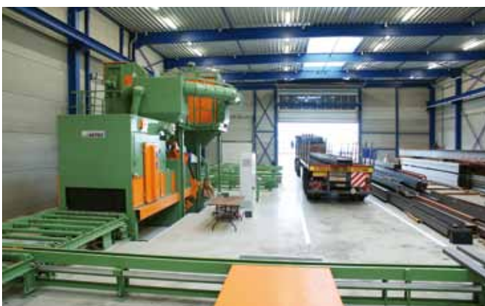
Dwarstransporten verbinden de rollenbaanstraalinstallatie met de zaag-boor-installaties.
