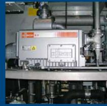
Vakuumpumpe für die Trocknung
